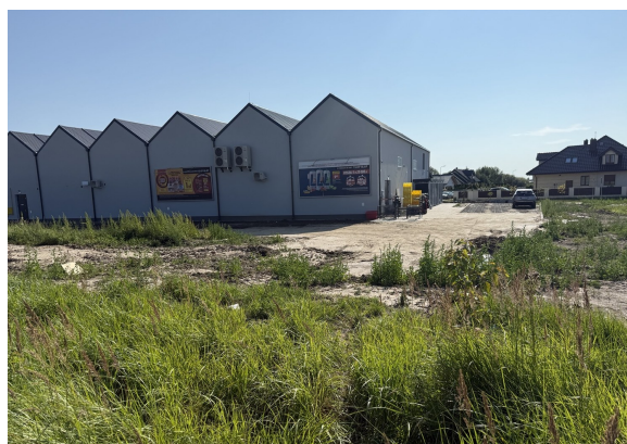
Zaplecze obiektu handlowego, dojazdy oraz sąsiednia zabudowa mieszkaniowa.
