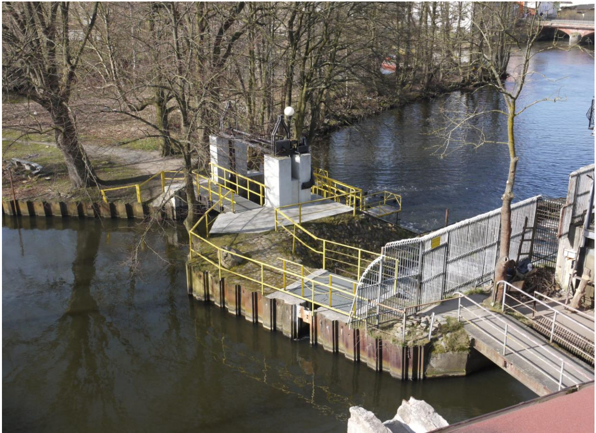
Budowle hydrotechniczne na rzece Wieprzy fot 2017r. – zbiory prywatne autorów studium
