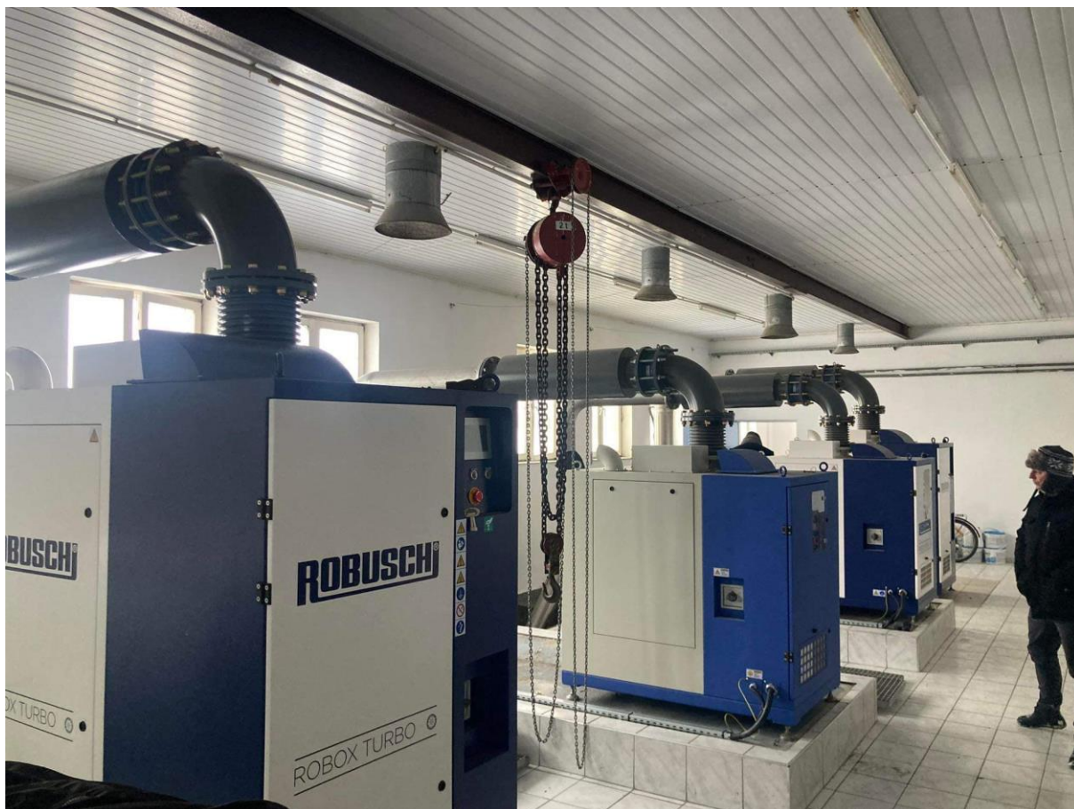
Prace modernizacyjne w oczyszczalni ścieków w roku 2023 kosztowały ponad 5 milionów złotych
