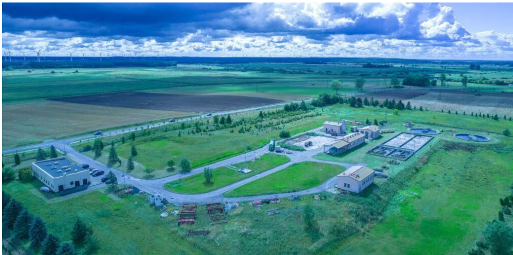
Modernizacja oczyszczalni to najbardziej kosztowna inwestycja rozpoczęta w 2022 roku
