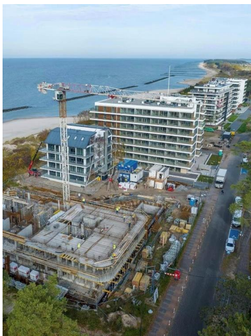
Nowe obiekty powstają między innymi wzdłuż ulicy Słowińskiej w Darłówku
