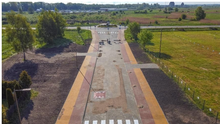
Nowa droga poprawiła komunikację w zachodniej części DarłóWka
