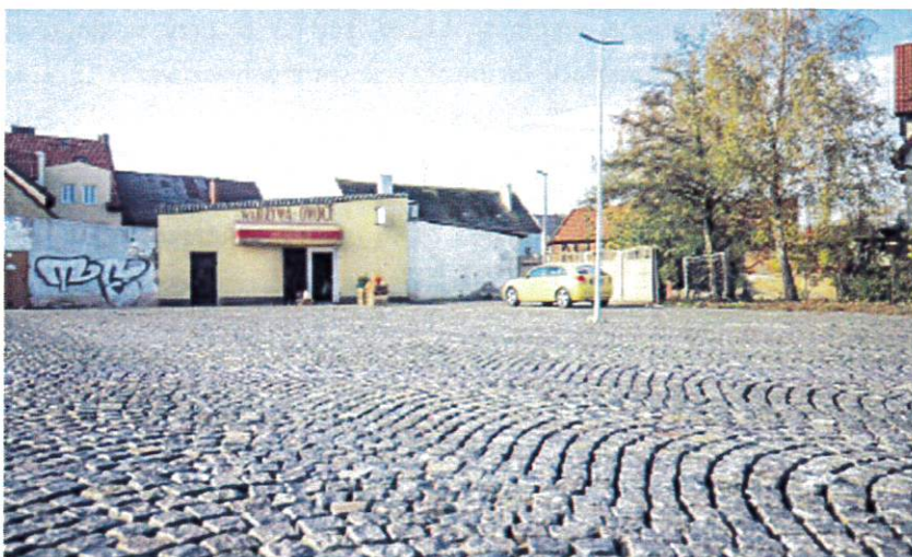
W roku 2020 dokończono budowę targowiska przy ul. Stodolnianej
