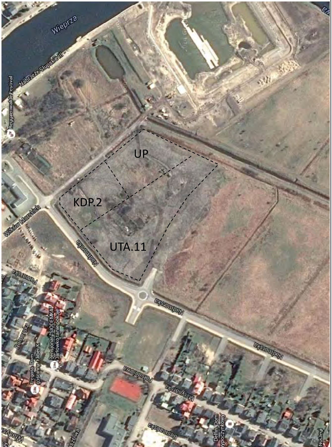
Teren UTA.11, UP, KDP.2 – teren nadsypany
